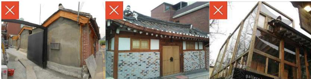
외벽 시멘트 마감
