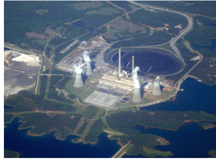
Robert W. Scherer Power Plant, Juliette, Georgia. [via Wikimedia]
